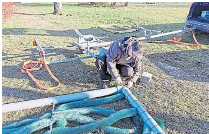
Der Vorsitzende Guido Wörmann mit einem der beiden wetterbeständigen HT-Rohr-Rahmen. Im Hintergrund einer der Betonklötze, die zur Verankerung im Gewässergrund dienen.
